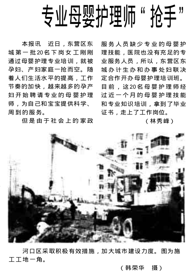
河口区采取积极有效措施,加大城市建设力度。图为施工工地一角。(韩荣华 摄)
